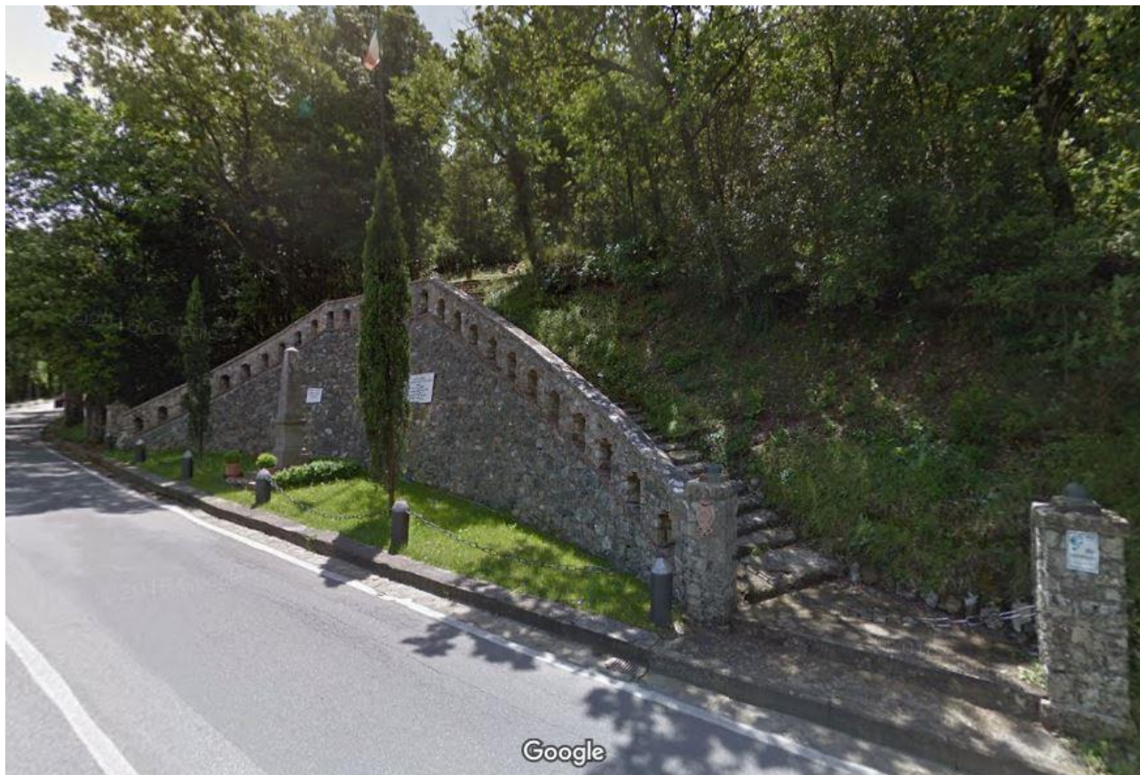
Scalinata nel Parco della Rimembranza di Impruneta (FI).
