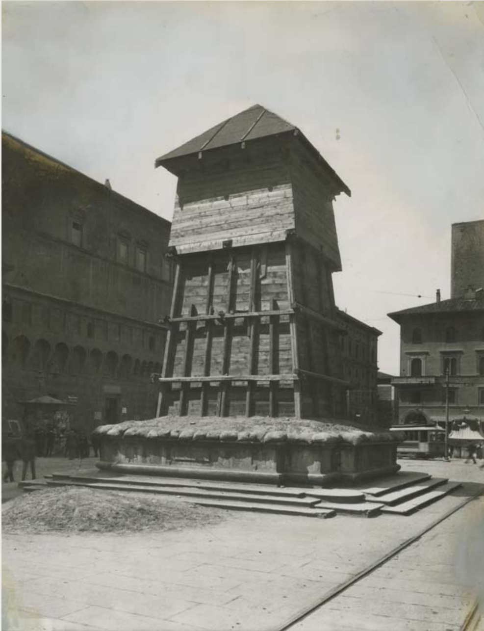
Fig. 1: Bologna, Piazza Nettuno, la fontana del Nettuno nascosta dall'armatura protettiva contro i bombardamenti durante la prima guerra mondiale.
