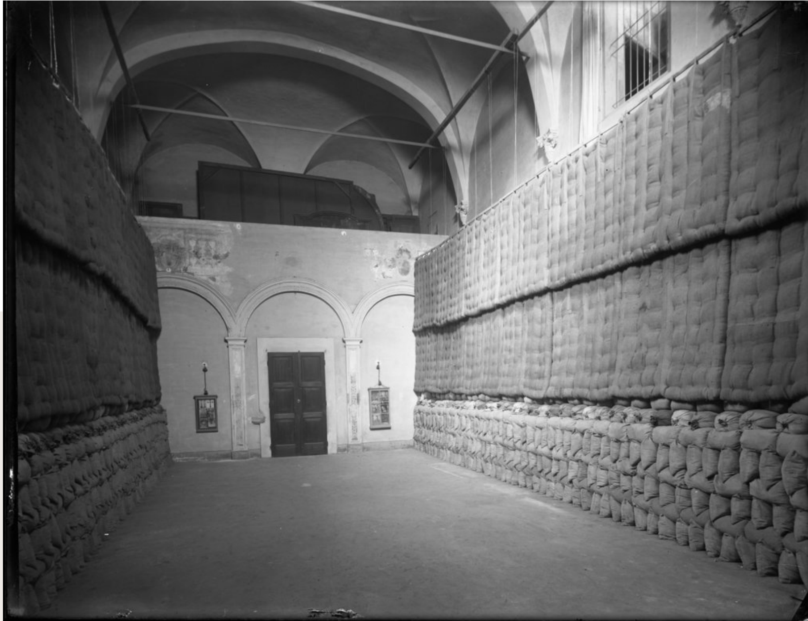
Fig. 5: Bologna, oratorio di Santa Cecilia, interno: veduta delle protezioni antiaeree poste in opera a salvaguardia degli affreschi delle pareti laterali, inventario N_000166.
