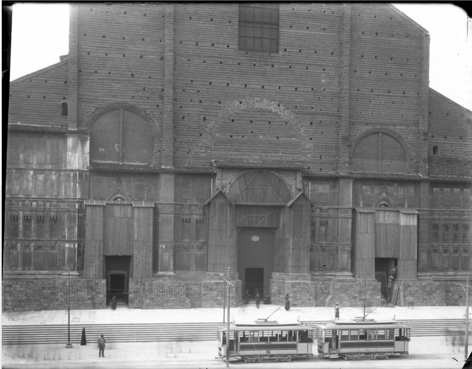
Fig. 9: Basilica di San Petronio, facciata: veduta delle protezioni antiaeree poste in opera a salvaguardia dei tre portali e dello zoccolo lapideo, inventario N_000195.
