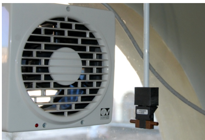
Fig. 2 – estrattore d'aria collocato alla finestra dell'Archivio negativi
