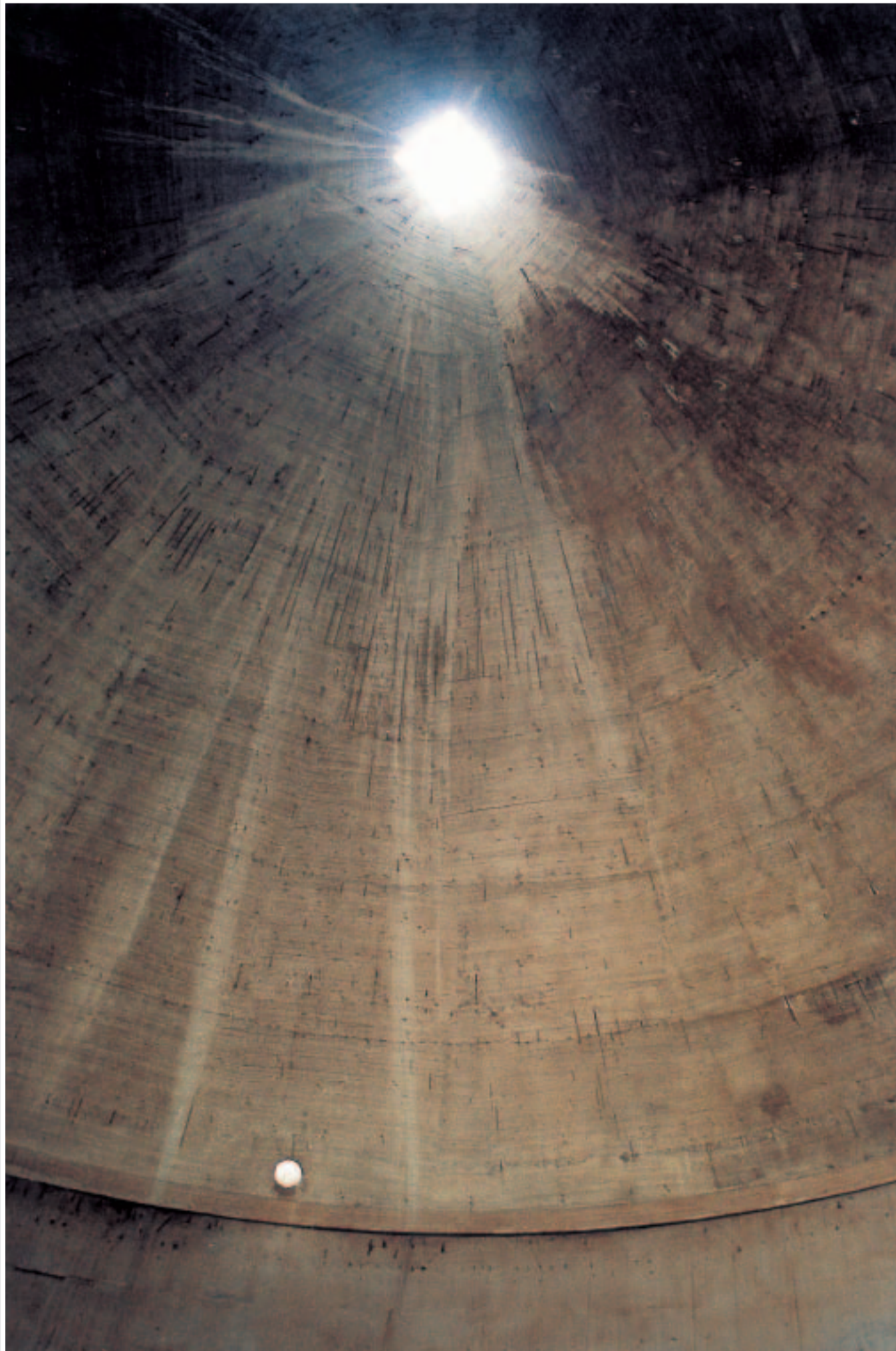
porto marghera. ex stabilimento enichem. interno del silos per la fosforite. foto iccd, giugno 2000
