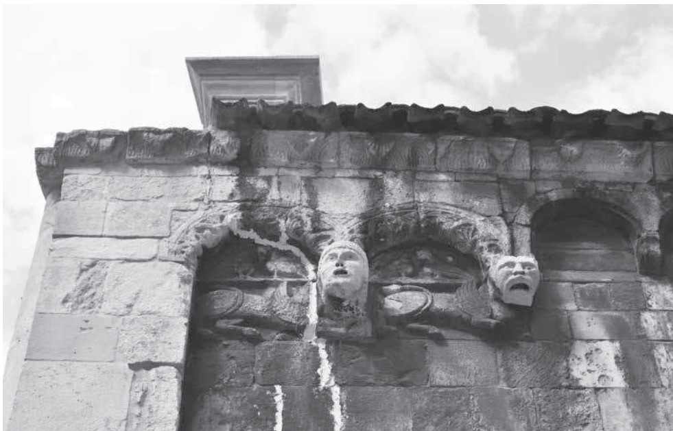
Fig. 4. Chiesa di Santa Maria in Piazza, dettaglio del fronte meridionale. Depositi e croste nere in corrispondenza degli aggetti e degli elementi scultorei maggiormente articolati.
