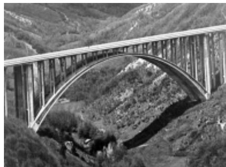
Fig. 3 – Viadotto sul torrente Aglio nel tratto transappenninico (G. Oberti, B. Gentilini, A. Romagnoli, 1957-1959)
