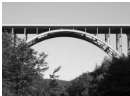
Fig. 2 – Viadotto sul torrente Gambellato nel tratto transappenninico (G. Krall, 1960)
