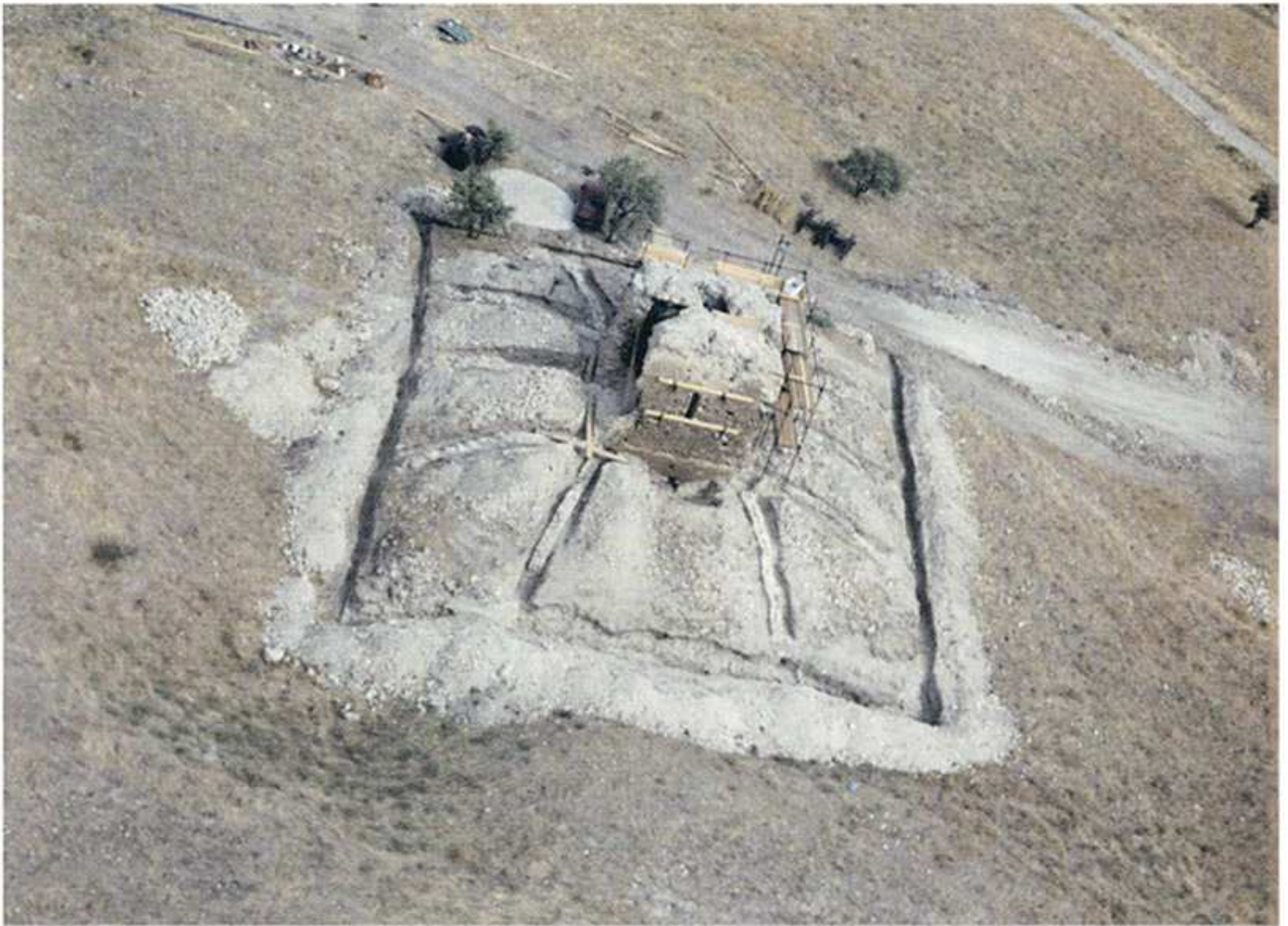
Fig. 8b – Fiorentino, veduta aerea della torre orientale durante il restauro (Laboratorio centro aerofotografico, Università di Bari, 1988).
