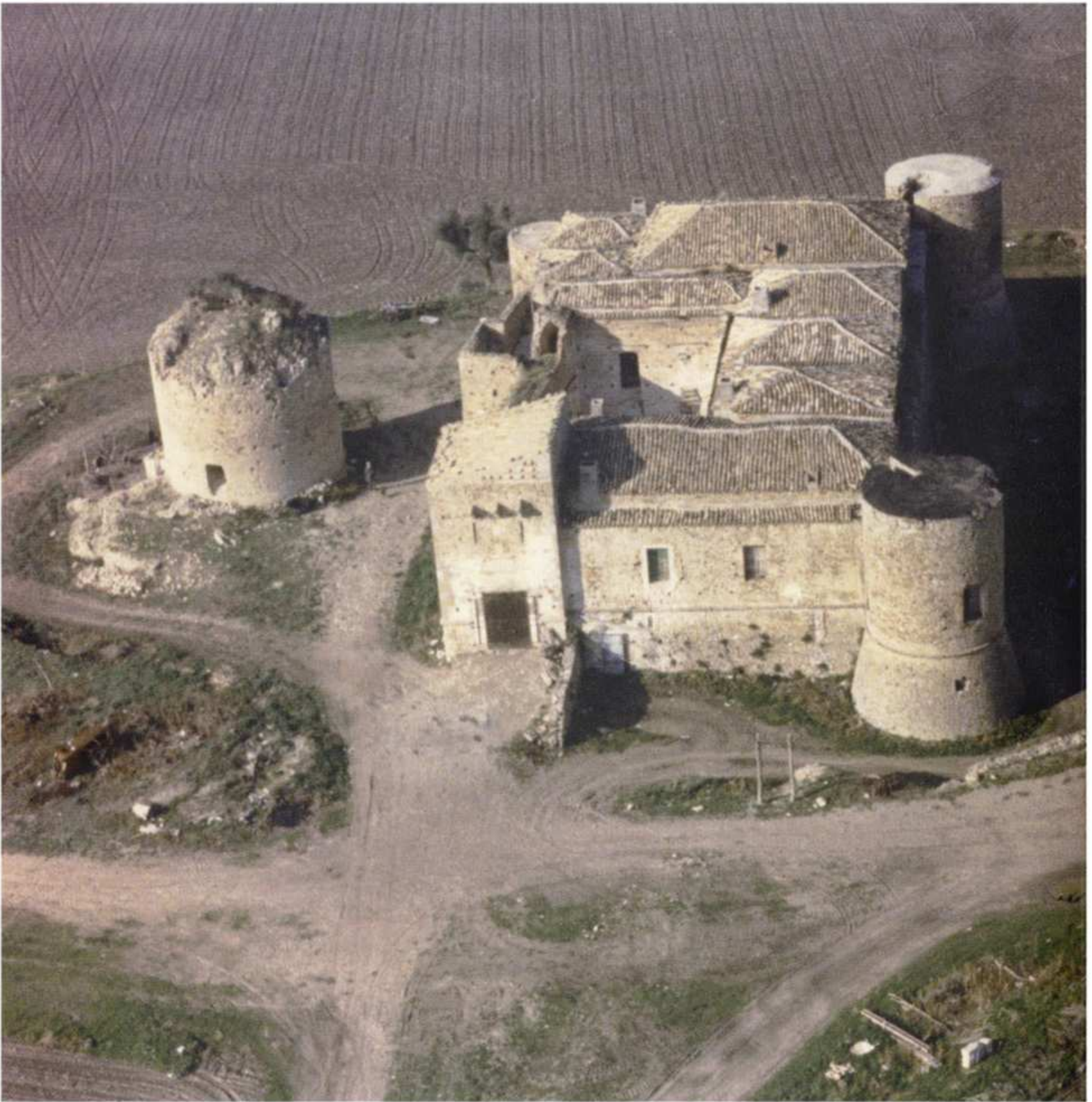
Fig. 21 – Dragonara, veduta aerea del castello (Laboratorio centro aerofotografico, Università di Bari, 1993).
