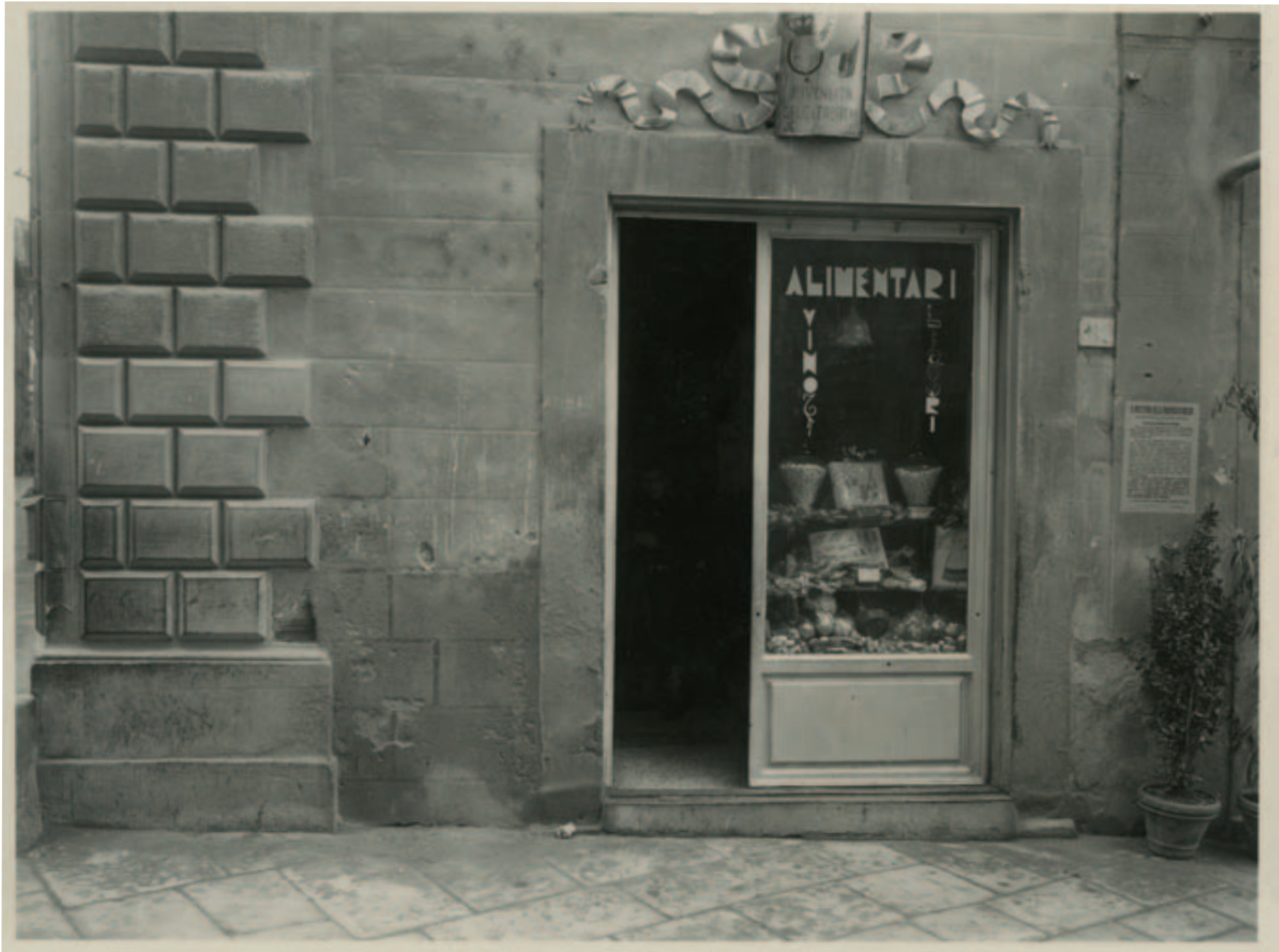
Antonio Ceccato, Arezzo: Palazzo Arcangeli, particolare del bugnato d'angolo , 1936
