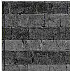
Ospedale dei Pellegrini, facciata (della confraternita di S. Domenico), 1333
